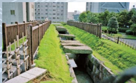
神田上水石樋 (本郷給水所公苑)
