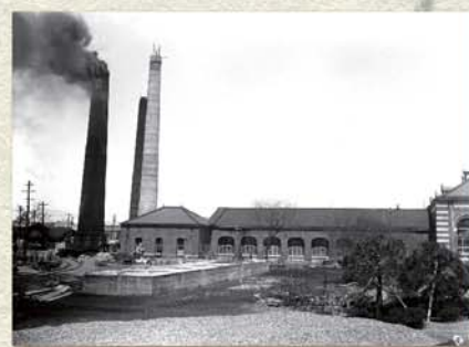
淀橋浄水場機関室と煙突(大正14年4月)
